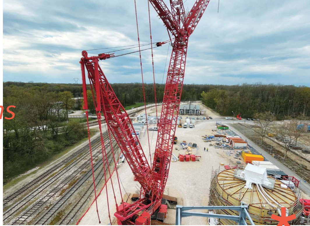
Inovyn's Tavaux site (France). Site Inovyn à Tavaux (39).
